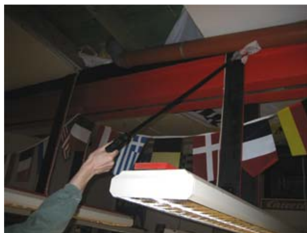
Schwimmen, die Zweite: Auch das Dach bekam Probleme mit den Wassermassen vom Himmel und musste kurzfristig „bearbeitet“ werden . . .
